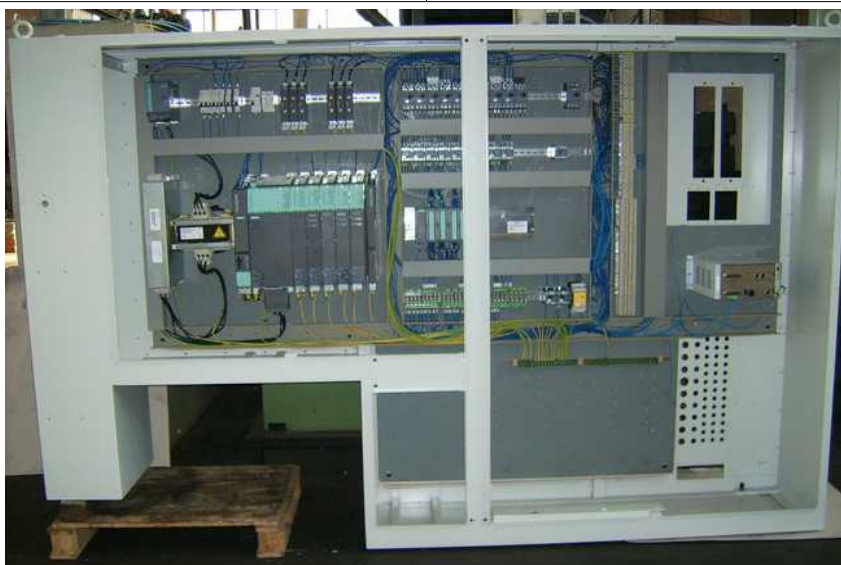
Realizzazione armadio elettrico
